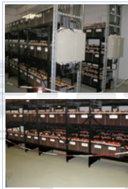
Рис. 23 Смонтированные батареи Classic Energy Bloc
